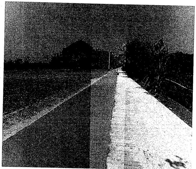
๖. โครงการก่อสร้างถนนคอนกรีตเสริมเหล็ก สายเลียบคลองส่งน้ำ สาย M๑R บ้านจันอูย หมู่ที่ ๕ โดยดำเนินการก่อสร้างถนนคอนกรีตเสริมเหล็ก ขนาดกว้าง ๓.๕๐ เมตร ยาว ๑๙๙ เมตร หนา ๐.๑๕ เมตร หรือรวมพื้นที่ผิวจราจรไม่น้อยกว่า ๖๙๖.๕๐ ตารางเมตร ไหล่ทางกว้างเฉลี่ยข้างละ ๐.๕๐ เมตร ก่อสร้างตามแบบแปลนและรายละเอียดที่ อบต.ลาดหญ้ากำหนด
