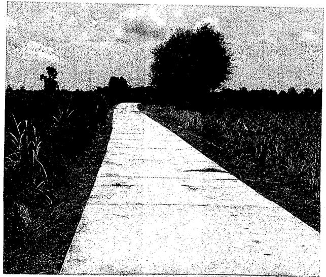
๕. โครงการก่อสร้างถนนคอนกรีตเสริมเหล็ก บริเวณบ้านลุงสุวรรณ ครูทวงษ์ บ้านหนองแก หมู่ที่ ๗ โดยดำเนินการก่อสร้างถนนคอนกรีตเสริมเหล็ก ขนาดกว้าง ๕.๐๐ เมตร ยาว ๑๔๒ เมตร หนา ๐.๑๕ เมตร หรือรวมพื้นที่ผิวจราจรไม่น้อยกว่า ๗๑๐ ตารางเมตร ก่อสร้างตามแบบแปลนและรายละเอียดที่ อบต.ลาดหญ้ากำหนด
