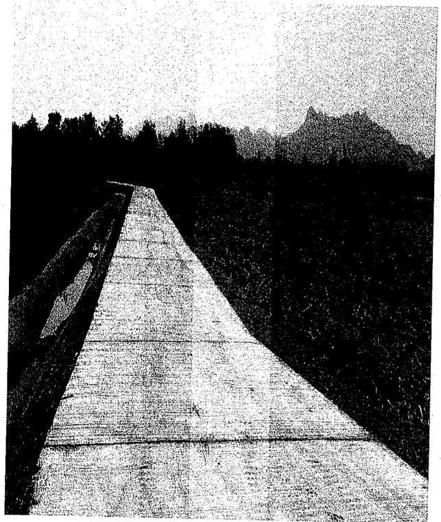
๗. โครงการก่อสร้างถนนคอนกรีตเสริมเหล็ก บริเวณคลองส่งน้ำ สาย M๒L บ้านท่าหวี หมู่ที่ ๔ โดยดำเนินการก่อสร้างถนนคอนกรีตเสริมเหล็ก ขนาดกว้าง ๔ เมตร ยาว ๑๘๕ เมตร หนา ๐.๑๕ เมตร หรือรวมพื้นที่ผิวจราจรไม่น้อยกว่า ๗๔๘ ตารางเมตร ไหล่ทางกว้างเฉลี่ยข้างละ ๐.๕๐ เมตร ก่อสร้างตามแบบแปลนและรายละเอียดที่ อบต.ลาดหญ้ากำหนด
